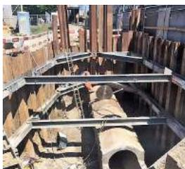
von uns erstellten Bauwerke tragen dadurch unsere ganz spezielle «Handschrift». Nur einige Beispiele: Im Regenbecken Oberwinterthur wird mit riesiger Tiefbaupower an Eulachquerung und gespriessten Schachtarbeiten gearbeitet. (Foto siehe andere Spalte)
