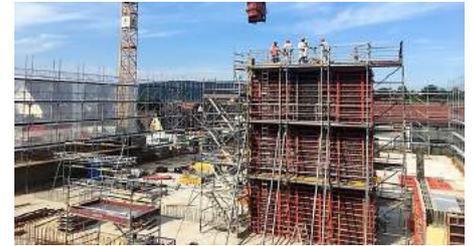
In Beringen (oben) erstellen wir Sichtbetonwände in Höhe von 9.70 Meter in einem Guss!
